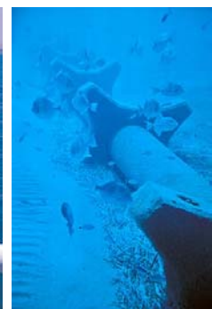
▲ Figura 55: Foto de un gasoducto ya instalado.
