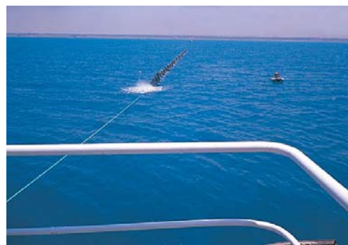
▲ Figura 54: transporte en superficie de tuberías para la construcción de un gasoducto.
