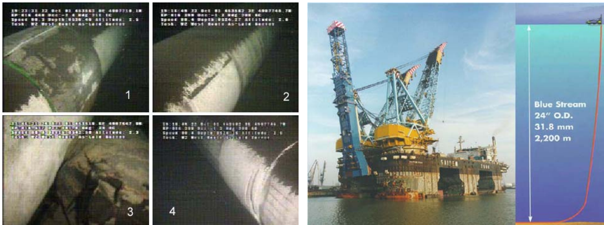
▲ Figura 56: Filmación con ROV de un gasoducto: (1) estado de un ánodo de sacrificio; (2) estado de una junta; (3) colocación sobre un bloque de piedra; y (4) daño en la unión de dos tramos. ▲ Figura 57: Proceso de colocación de un gasoducto por el procedimiento J-Lay .
