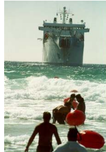
▲ Figura 48: Trabajos de conexión de cable con tierra.
